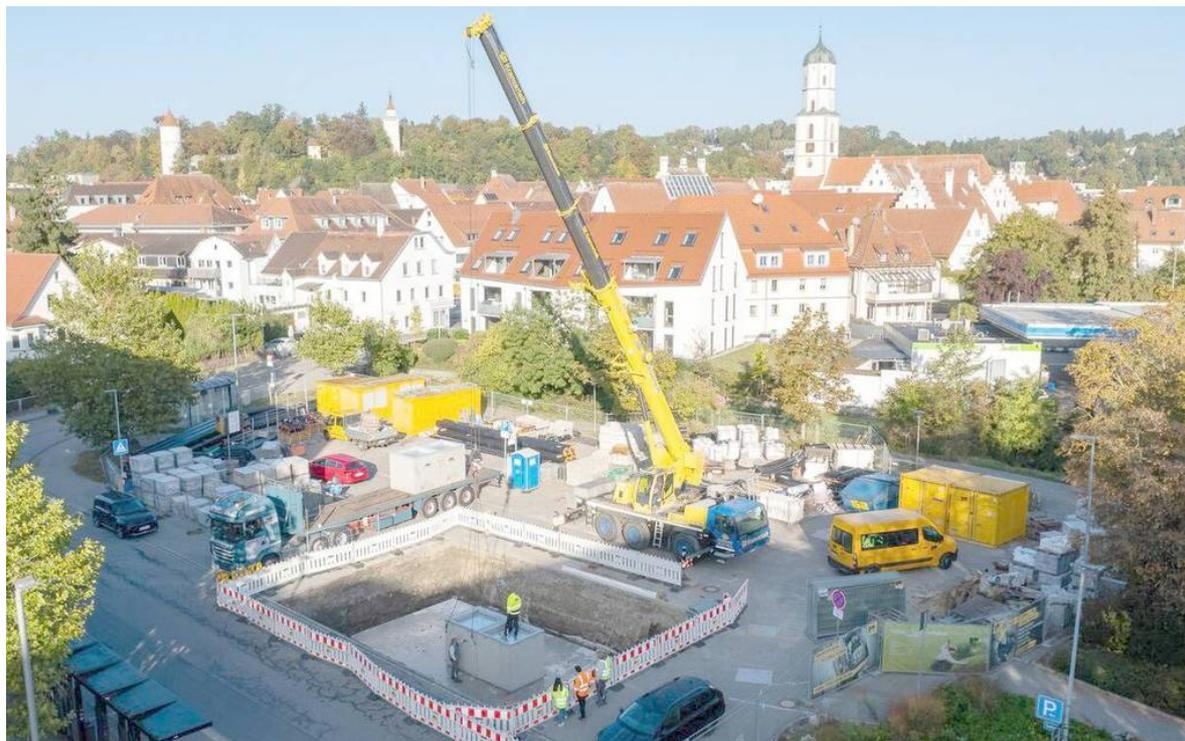
Ein 50-Tonnen-Autokran hob die vier Tonnen schweren Betonbehälter in die Grube. (Foto: Firma Grüner und Mühlshlegel)
